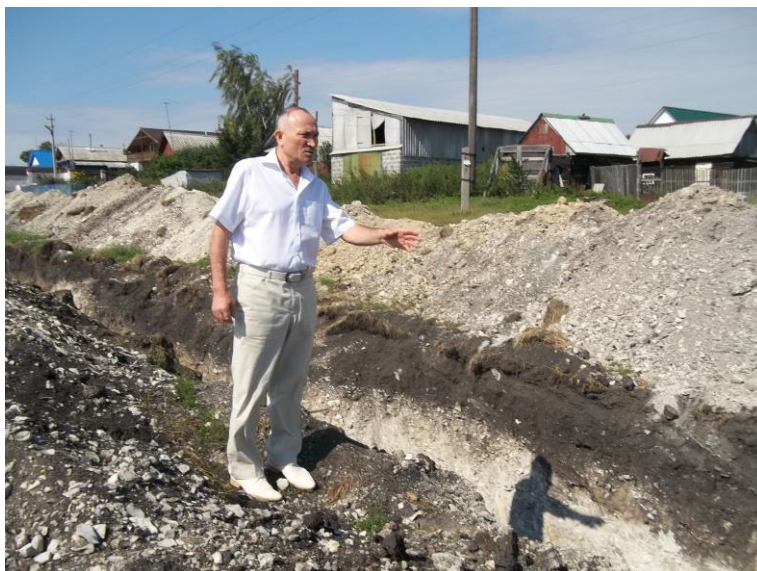
Н.Г.АБРАМОВ ОСМАТРИВАЕТ ХОД СТРОИТЕЛЬСТВА ВОДОПРОВОДА 25 АВГУСТА 2013 ГОДА.
