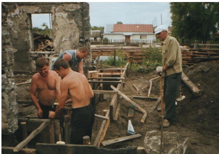
Таким выглядел дом после пожара. Василий Архипов, Юрий Горячев (бригадир), Антон Генералов закладывают фундамент.
